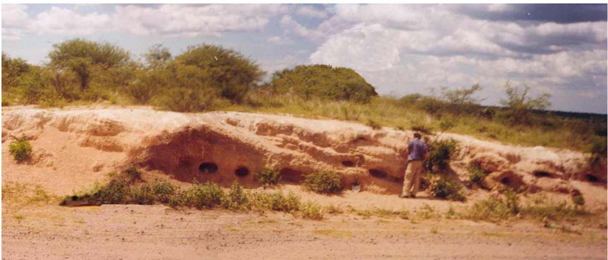
Foto 8: Corte de la ruta provincial 10 en areniscas limosas de la Formación Las Cañas.
