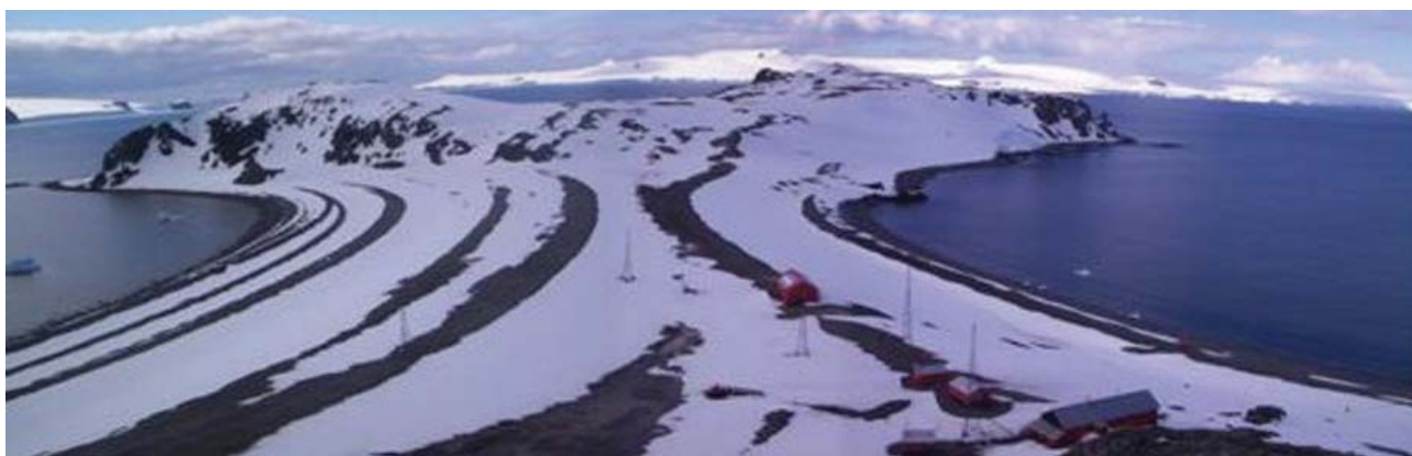
Fotografía 2. Vista general de la base Cámara; al fondo, la isla Greenwich. El aprovisionamiento de agua de la base presenta algunos inconvenientes; la laguna Mutto -próxima a la base y la más grande de la isla- actualmente tiene régimen temporario y durante la Campaña Antártica de Verano 1999/2000 se hallaba totalmente seca.
