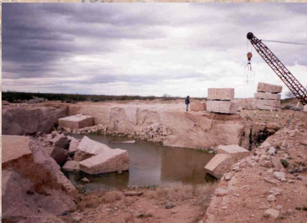
Frente de explotación de la cantera Larrosa. A la derecha, pluma para carga de bloques.
