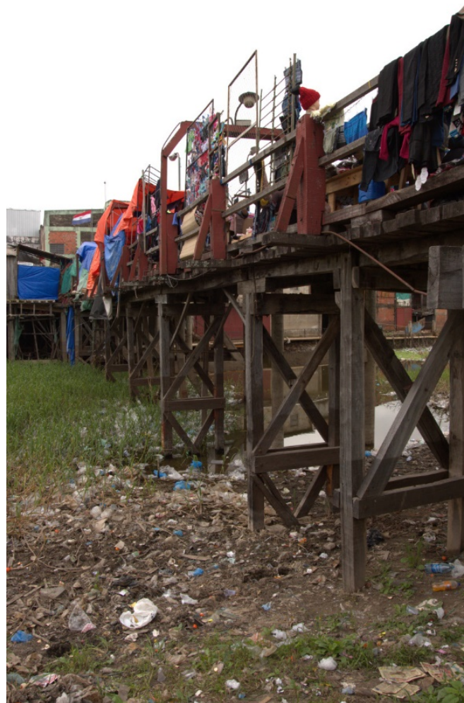
Figura N° 8: Vista del puente de madera, desde la base del terraplén
