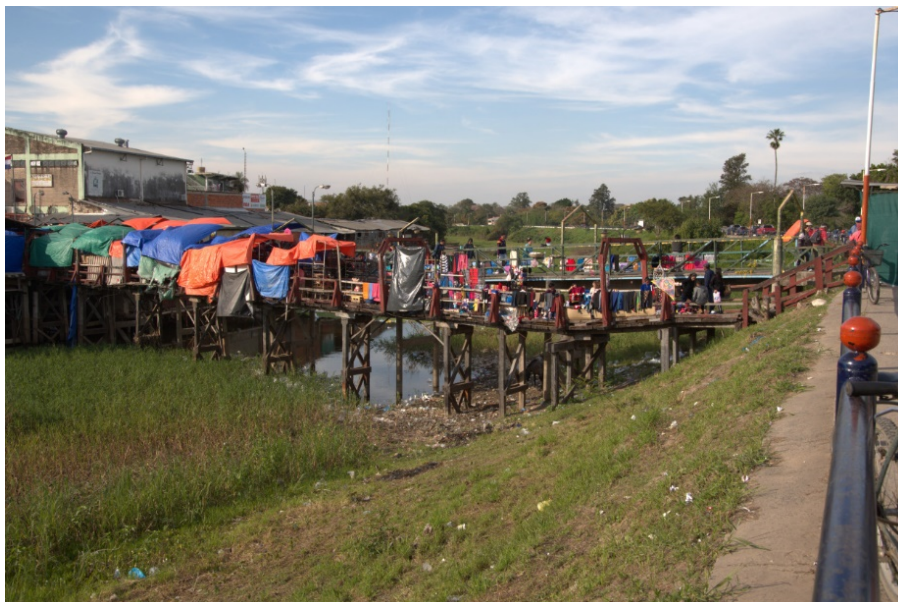
Figura N° 7: Pasarela de la Amistad
