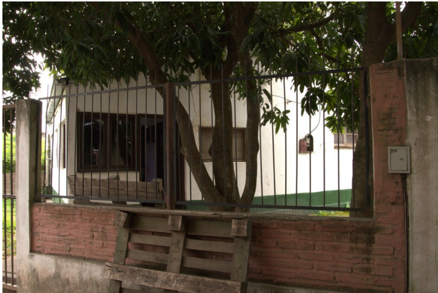
Figura N° 12: Vista de las instalaciones de Gendarmería Nacional
