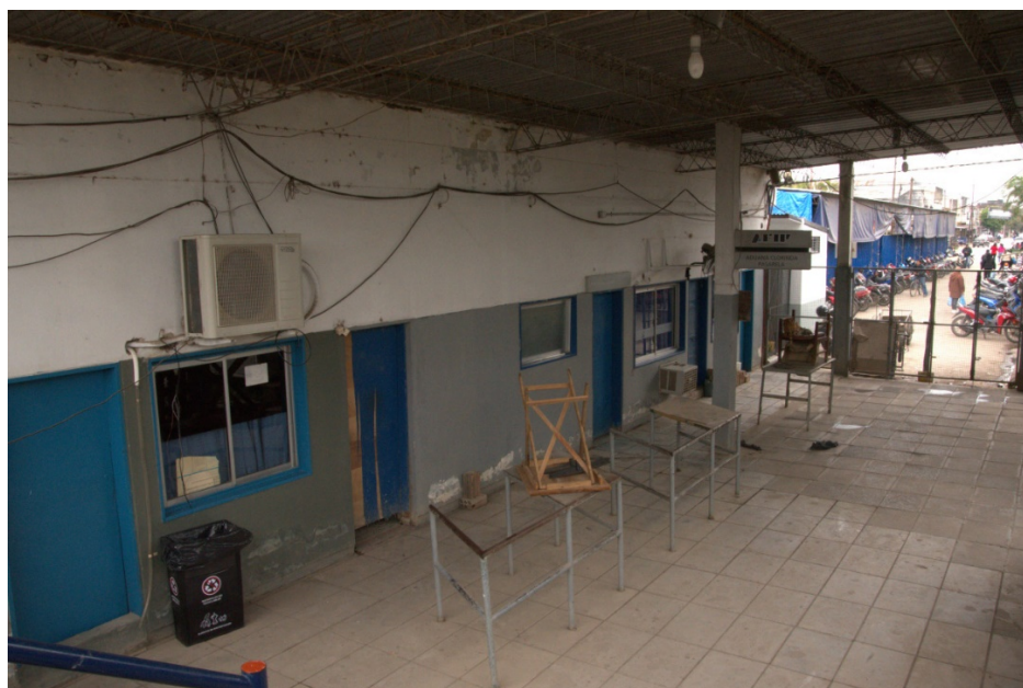
Figura N° 11: Vista de las oficinas del Puesto Fronterizo
