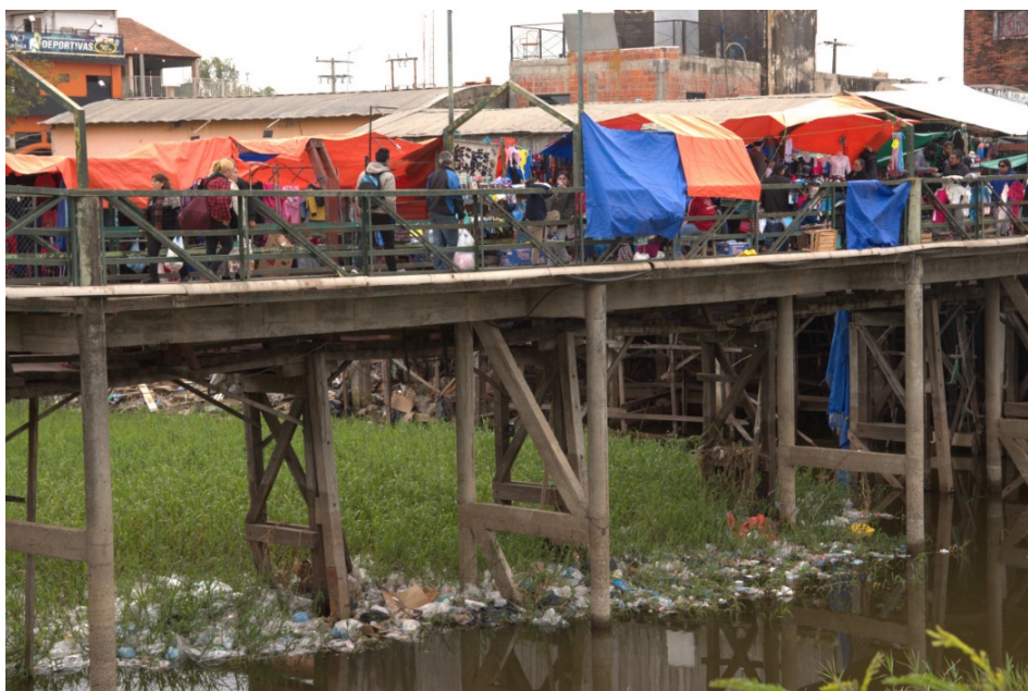
Figura N° 9: Vista del puente de hormigón, desde el terraplén
