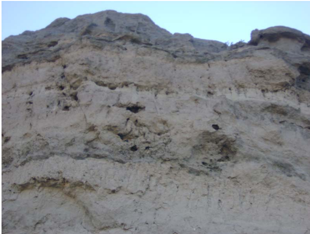
Se observa la heterogeneidad litológica, en la parte superior los bancos más coherentes y por debajo las cavidades debidas al proceso de piping.
