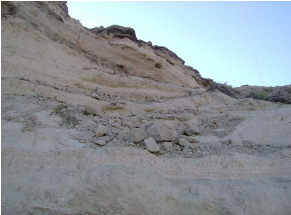
Caída de bloques reciente aldaño al sector más comprometido
