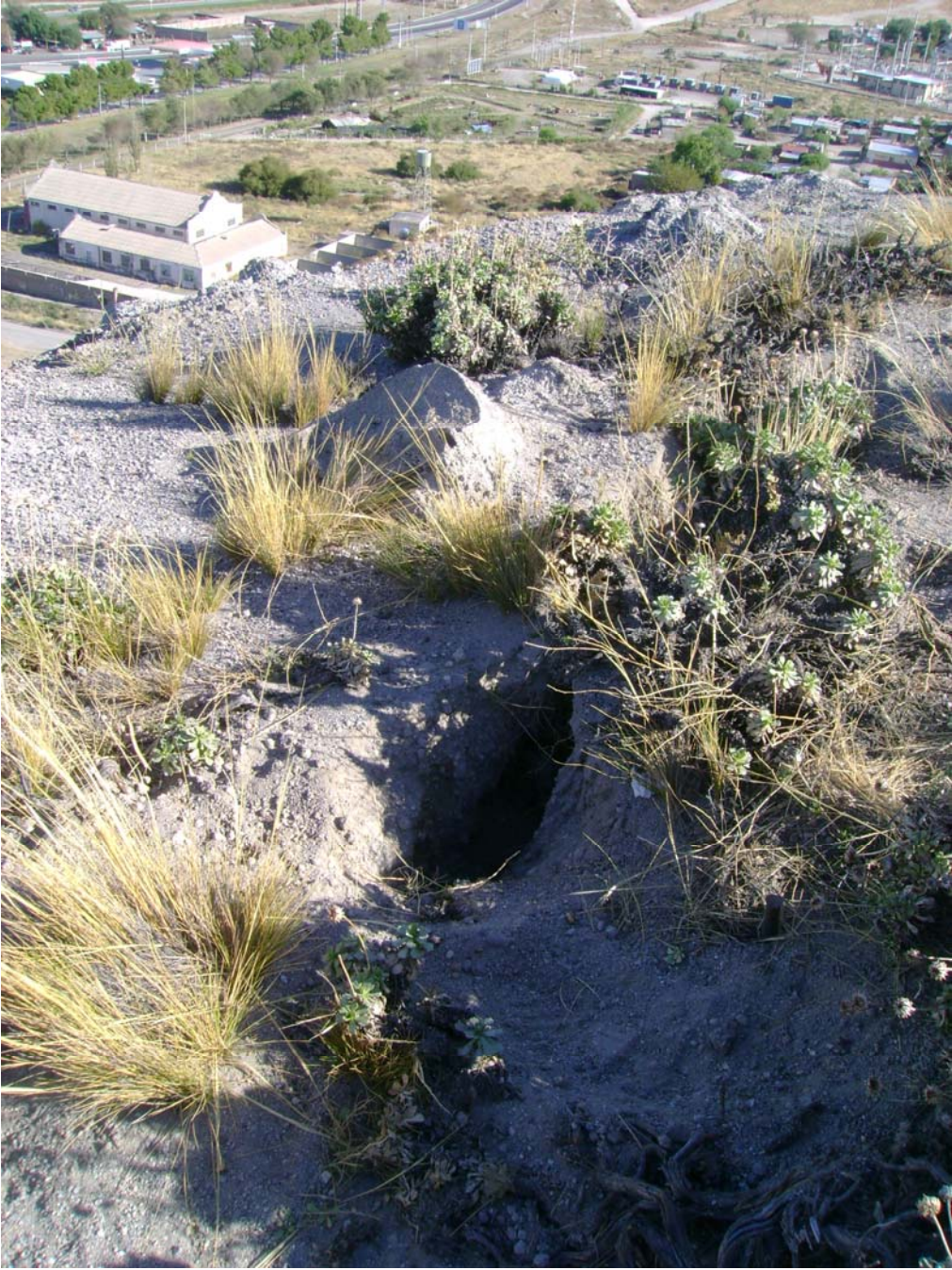
Vista de la grieta principal
