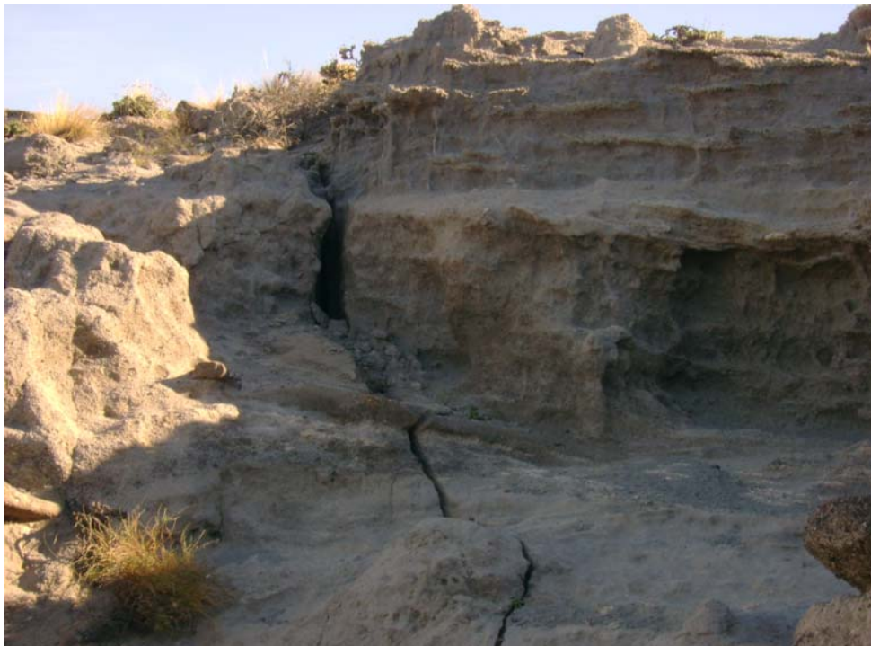
Detalle de la grieta
