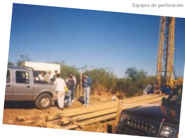
Equipos de perforación
